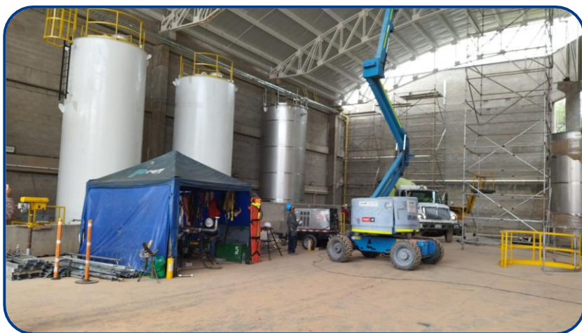
FABRICACION DE TANQUES Y CONSTRUCCION PANTA DE AMONIACO
