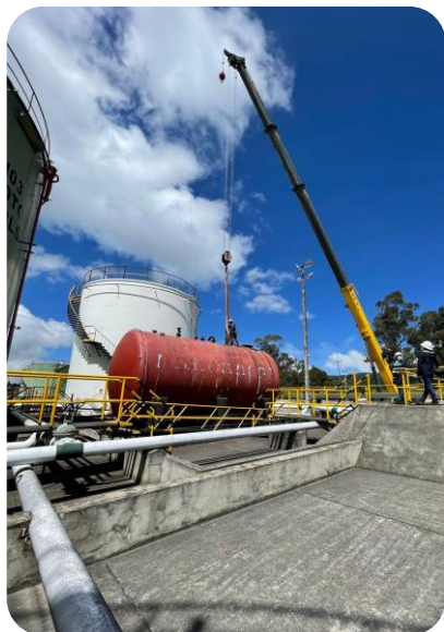
MONTAJE TANQUES 21000 GAL
