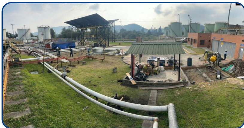
AMPLIACION ESTACION DE COMBUSTIBLE, TUBERIA, TANQUES Y CASA BOMBAS
