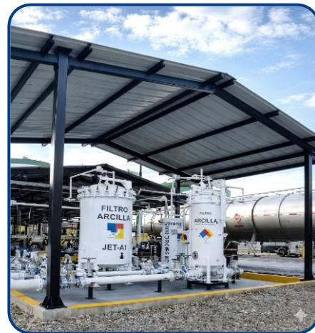
CONSTRUCCION SISTEMA FILTRACION JET A 1 Y CASETA
